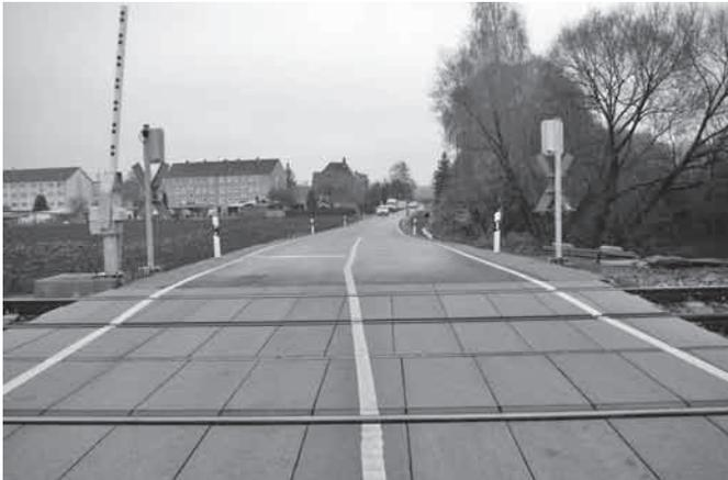
Im Rahmen des „Blinklichtprogramms der Deutschen Bahn AG und des Bundes“ wurde am Bahnübergang bei Zehma im Zuge der Kreisstraße K 515 die Änderung der vorhandenen Bahnübergangssicherungsanlage einschließlich des grundhaften Ausbaus der Fahrbahn und des Gehweges mit Straßenbeleuchtung realisiert.
