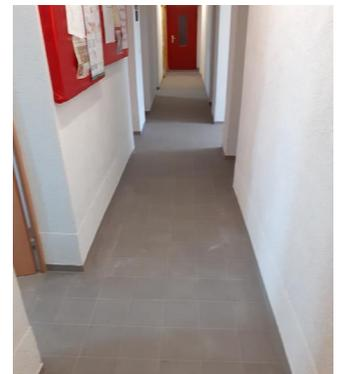
Dazu gehörten die Erneuerung des Fliesenbelages mit Estrichsanierung im Eingangsbereich/Flur sowie die Erneuerung von fünf Innentüren. Im Anschluss hat der Sportverein SV 1897 Zehma e. V. in Eigeninitiative Maler- und Putzarbeiten im Flur übernommen sowie in einem weiteren Raum den Fliesenbodenbelag erneuert. ▶
