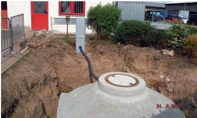
Die vorhandene Drei-Kammer-Grube aus Stahlbeton, errichtet als Neubau 1993, ist baulich noch weitestgehend in einem guten Zustand. Aufgrund der vorhandenen Betonkorrosion erfolgten nur oberhalb der Wasserlinie die Instandsetzung der beschädigten Trennwände sowie der Ersatz der Abdeckplatte und die Erneuerung des Konus.
