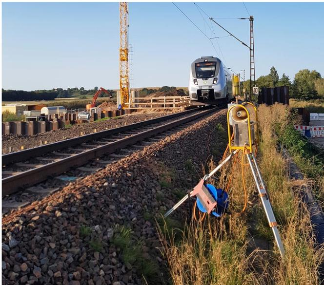
Automatisches Warnsystem (ATWS)
