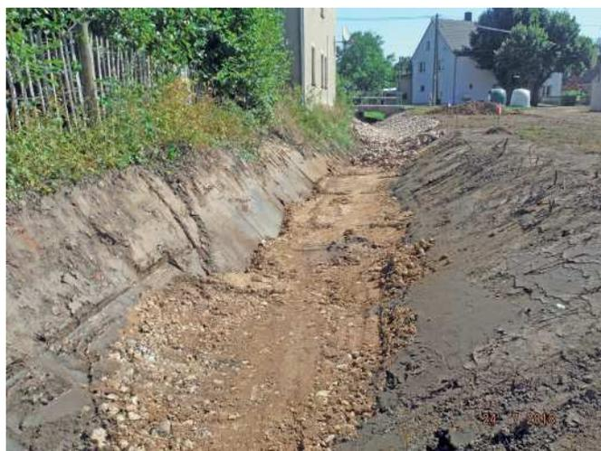
Im Rahmen der Gewässerbauarbeiten werden auch alle vorhandenen Abwassereinleitungen der Grundstücke sowohl in den Gewässerböschungen wie auch an den Verrohrungen (Rahmenprofile) wieder eingebunden.
