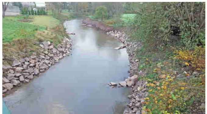
Insgesamt wurden rund 1.300 Tonnen Sedimentablagerungen aus dem Gewässer entfernt. Auch die Uferböschungen wurden in Teilbereichen wieder hergestellt/freigelegt und der Bewuchs beseitigt.
